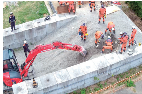
重機活用要領（提供：大阪市消防局）
