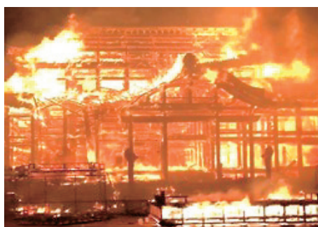
首里城跡での火災（那覇市消防局 提供）
